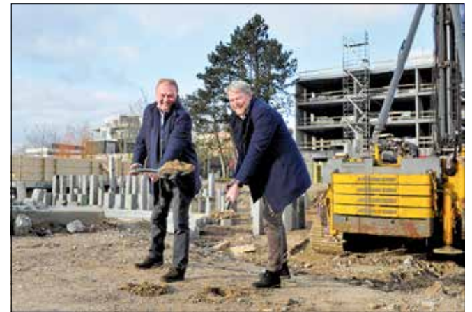
Bygherre Michael Willaume Andersen (tv.) og borgmester Tomas Breddam tager første spadestik til erhvervsbygningen Samspillet.
